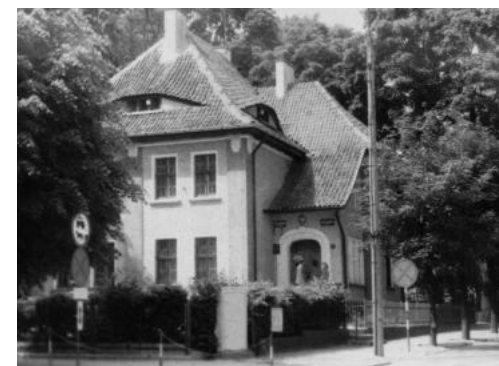
Ł-03. Stary budynek Szkoły Muzycznej w Elku (połowa lat pięćdziesiątych).
