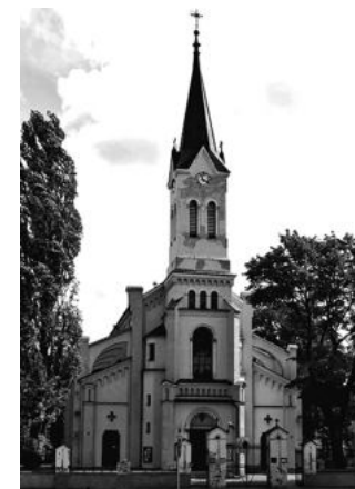
L-05. Kościół Trójcy Świętej w Grajewie (stan obecny).
