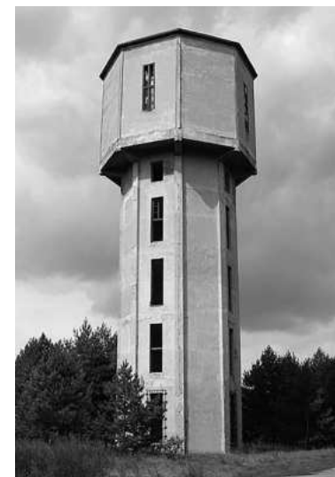
P-115. Wieża ciśnienia na stacji PKP w Czerwonym Borze.
