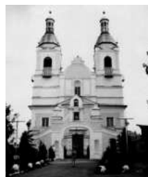
P-103. Kościół parafialny po przebudowie (1993).
